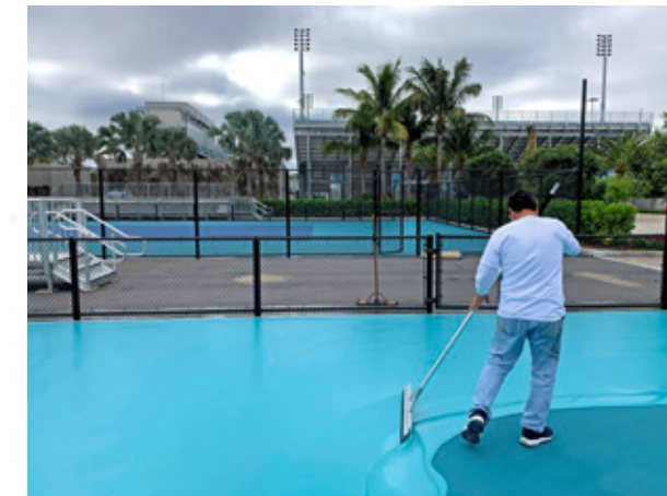
Auftragen des LM Topcoat
