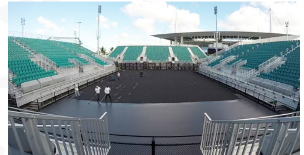
Auftragen des Laykold Resurfacer
